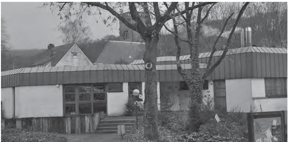
Das evangelische Gemeindezentrum soll abgerissen werden. Hier wollen die Johanniter barrierefreie Wohnungen bauen.
