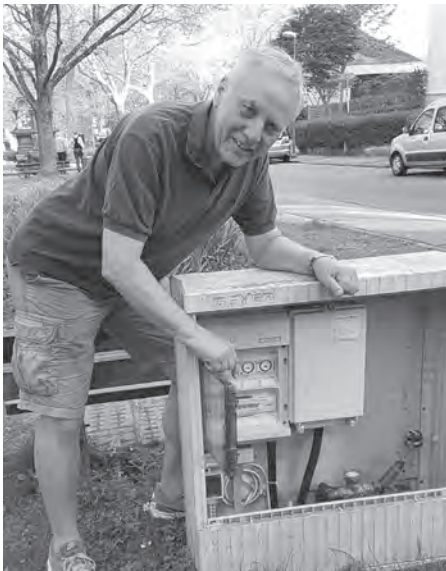
Im Leitstand der Brunnenanlage hatte ein Defekt die Probleme ausgelöst.
