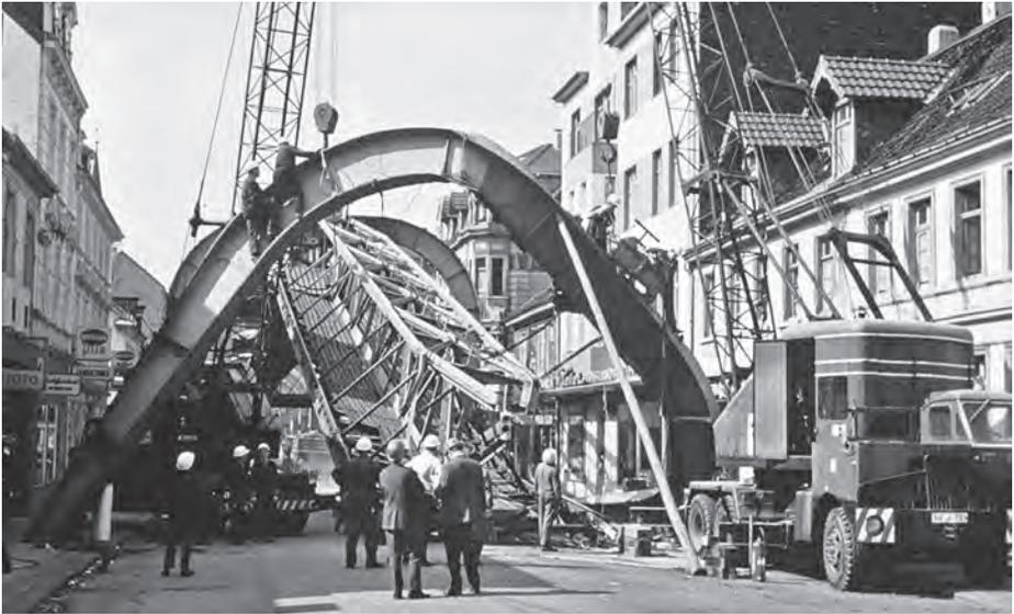
*50 Jahre ist das her: Der eingeknickte Pfeiler 87 riss das Schwebebahngerüst auf einer Länge von rund 80 Metern in die Tiefe. Foto: WSW*
