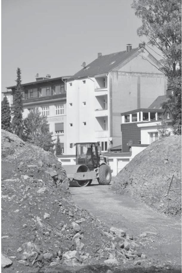
*Mit erheblichen Erdbewegungen sind die Gründungsarbeiten für das neue Reha-Zentrum in Sonnborn verbunden. Der Neubau wird auf einer Grundfläche von circa 1000 Quadratmetern auf dem Gelände der ehemaligen Straßenbahnwendeschleife rund 2300 Quadratmeter Nutz- und Praxisfläche einschließlich einem Bewegungsbad haben. Geschaffen werden zudem 50 Pkw-Stellplätze.*
