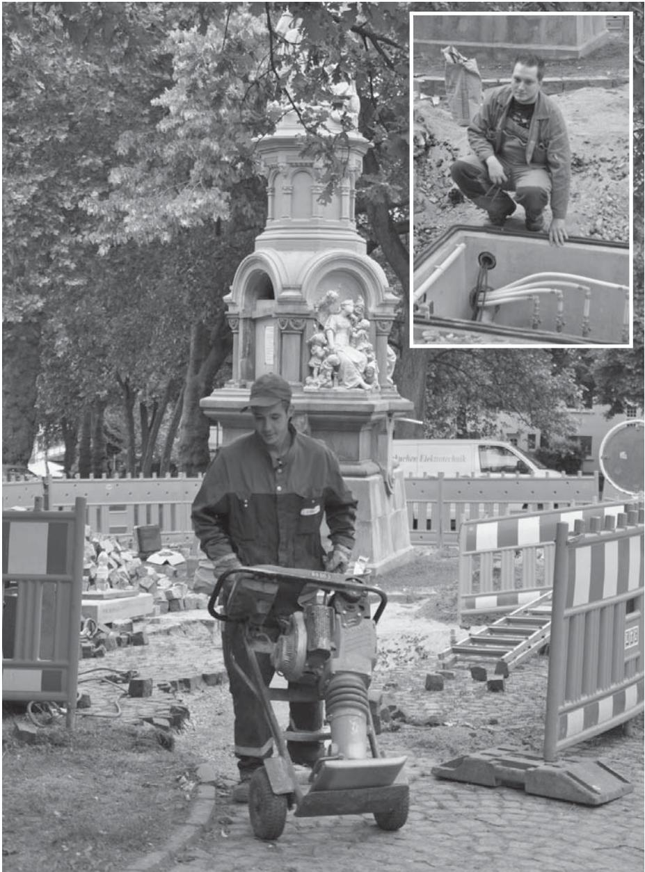
*Rückblick: Die Baustelle Märchenbrunnen am 27. Mai. Der Versorgungsschacht für Wasser und Strom ist unter dem Rondell eingebaut, die Wasserleitungen liegen. Nun ist der Elektriker an der Reihe. Anschließend wird die Pflasterung aus Grauwacke und Granit wieder hergestellt.*
