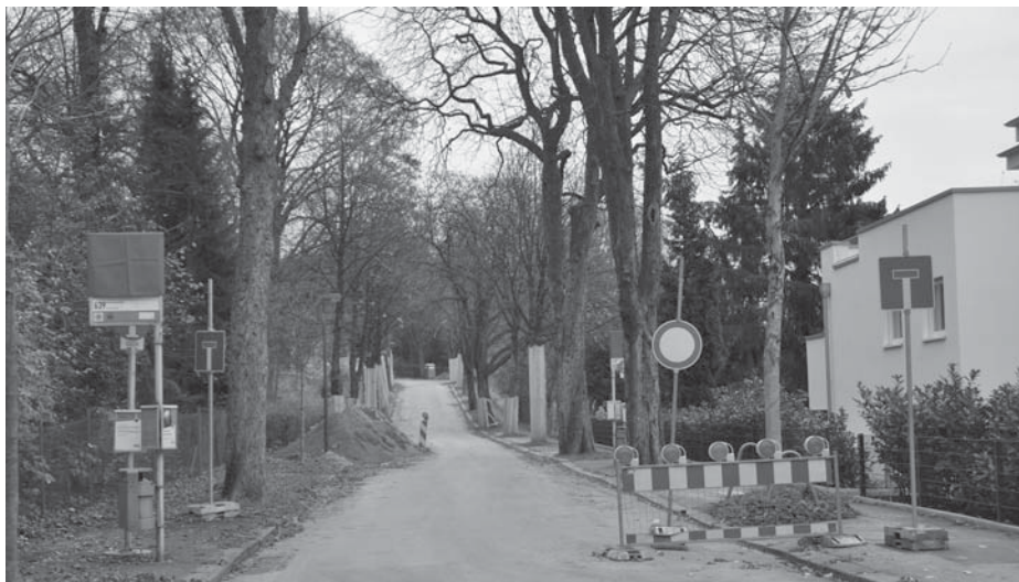
In der Straße Zur Waldesruh verlegen die Stadtwerke neue Leitungen.
